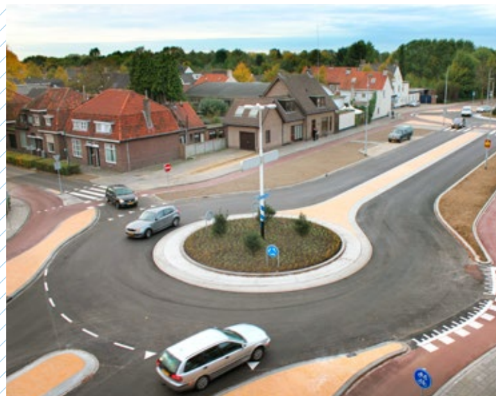
Aanleg van twee rotondes aan de Moergestelseweg in Oisterwijk.
